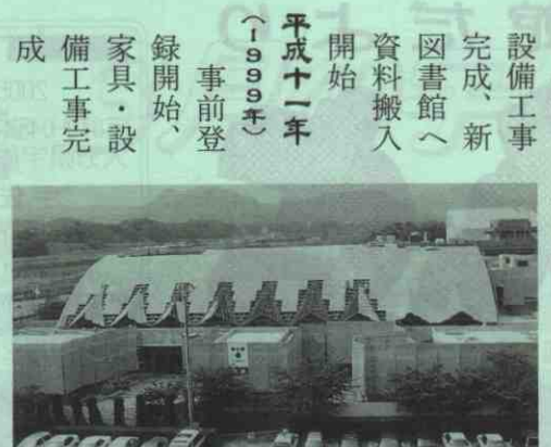
図書館建築工事中
