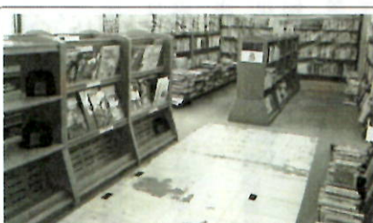
11/25・26 こどもスペースの ロールスクリーン・タイルカーペット貼替
